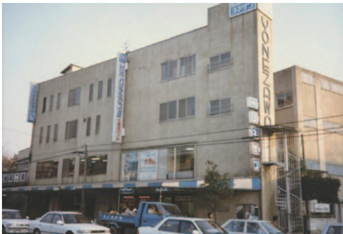
県庁通りのヨネザワ旧本店。当初は中央の立て看板より右側のビルのみ。後に左側を建て増した＝昭和54年
